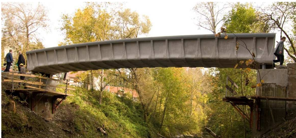
Obr. 2: Most z textilního betonu v Kempten (Allgäu), délka 17 m, výroba laminováním a stříkáním.
